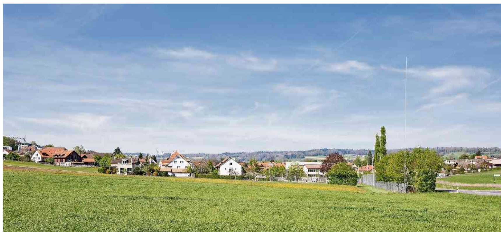
25 Meter hoch ist das Antennen-Gerüst, das vom Hertenstein her eingangs Freienwil neben der Hauptstrasse steht.
